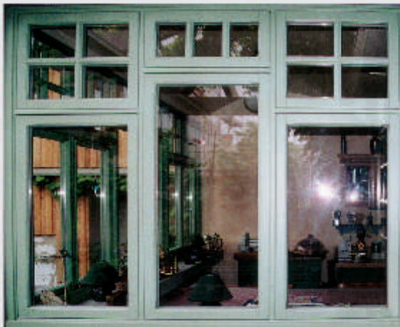
Sonderfenster (unten), eine nach außen zu öffnende Variante.
